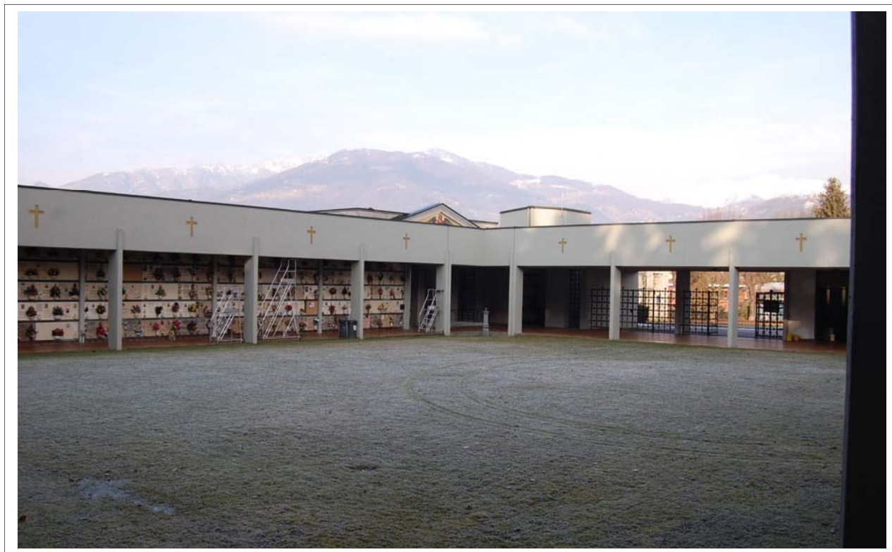
Immagine 5 – panoramica da sud est
