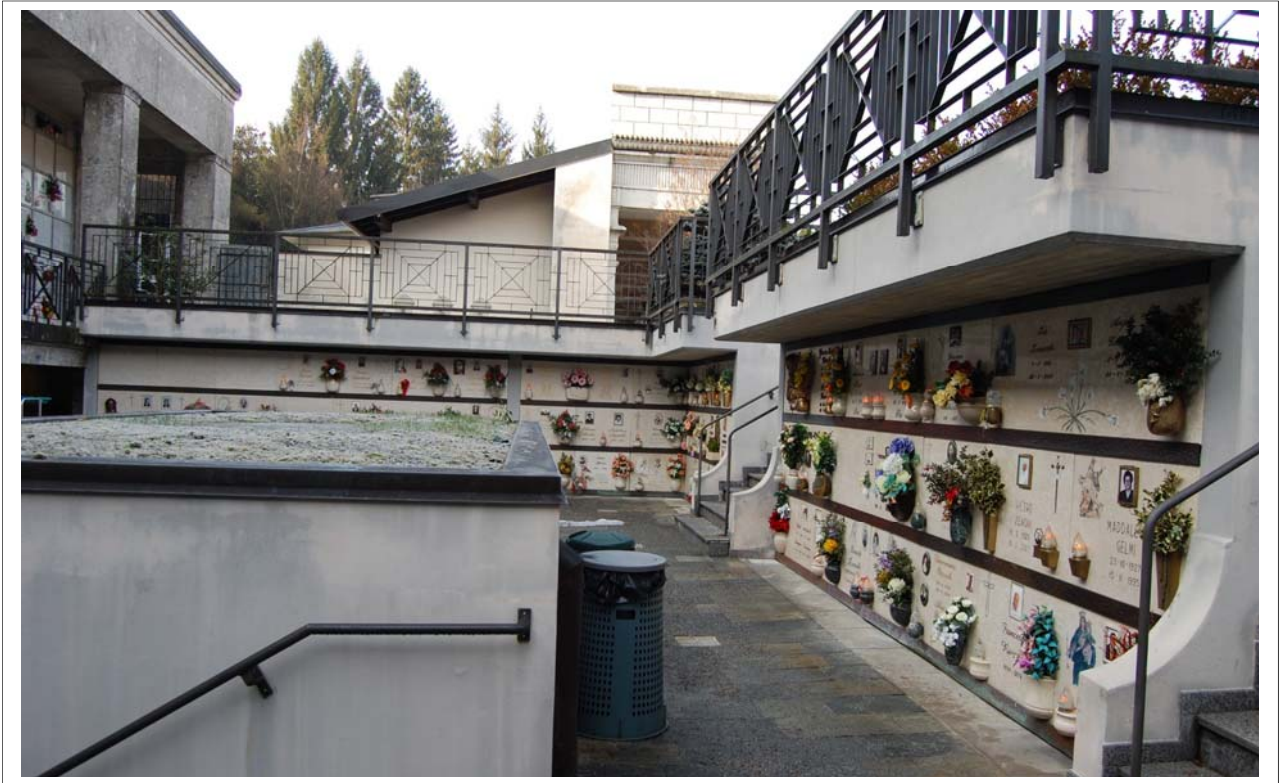
Immagine 25 – vista del mezzanino a quota -2.33 metri, in primo piano sulla destra il colombario denominato Prospetto C1, sullo sfondo il colombario denominato C
