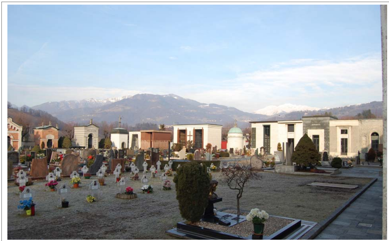
Immagine 9 – panoramica da sud - est
